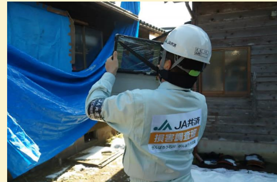
能登半島地震の損害調査の様子
